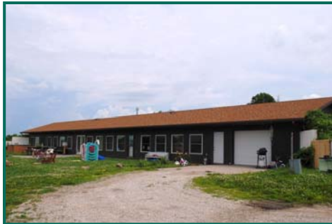
Parcel 2- Berm House
